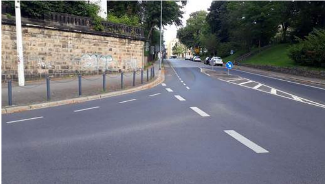
1: Sicht aus Richtung Südausgang/Jakobstunnel
